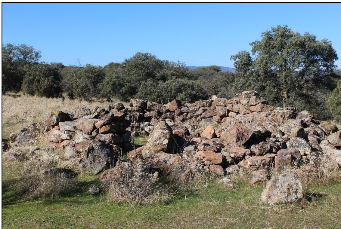
Fig. 2. Estado del bien antes de ser intervenido. Imagen de los autores.
