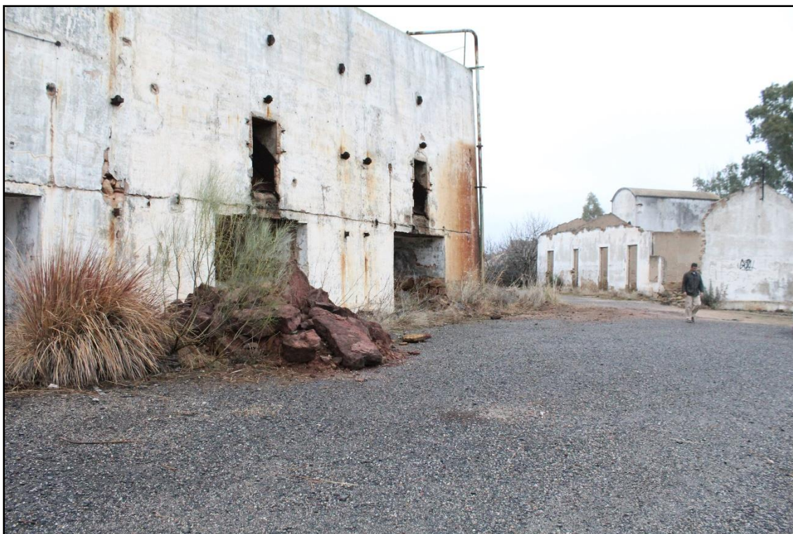
Fig. 3. Elementos constructivos de la explotación Adaro Nº1. Imagen de los autores.
