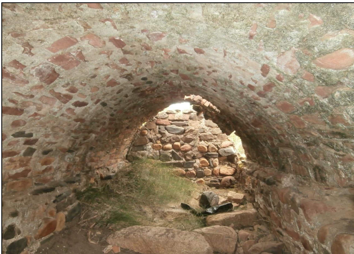
Fig. 2. Interior del molino. Imagen de los autores.
