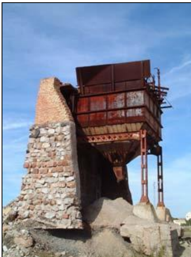
Fig. 3. Vista principal de la cabria. Imagen de los autores.
