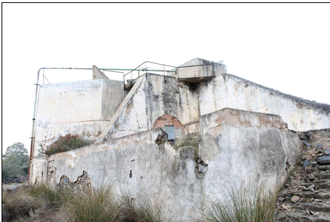
Fig. 2. Instalación del pozo. Imagen de los autores.
