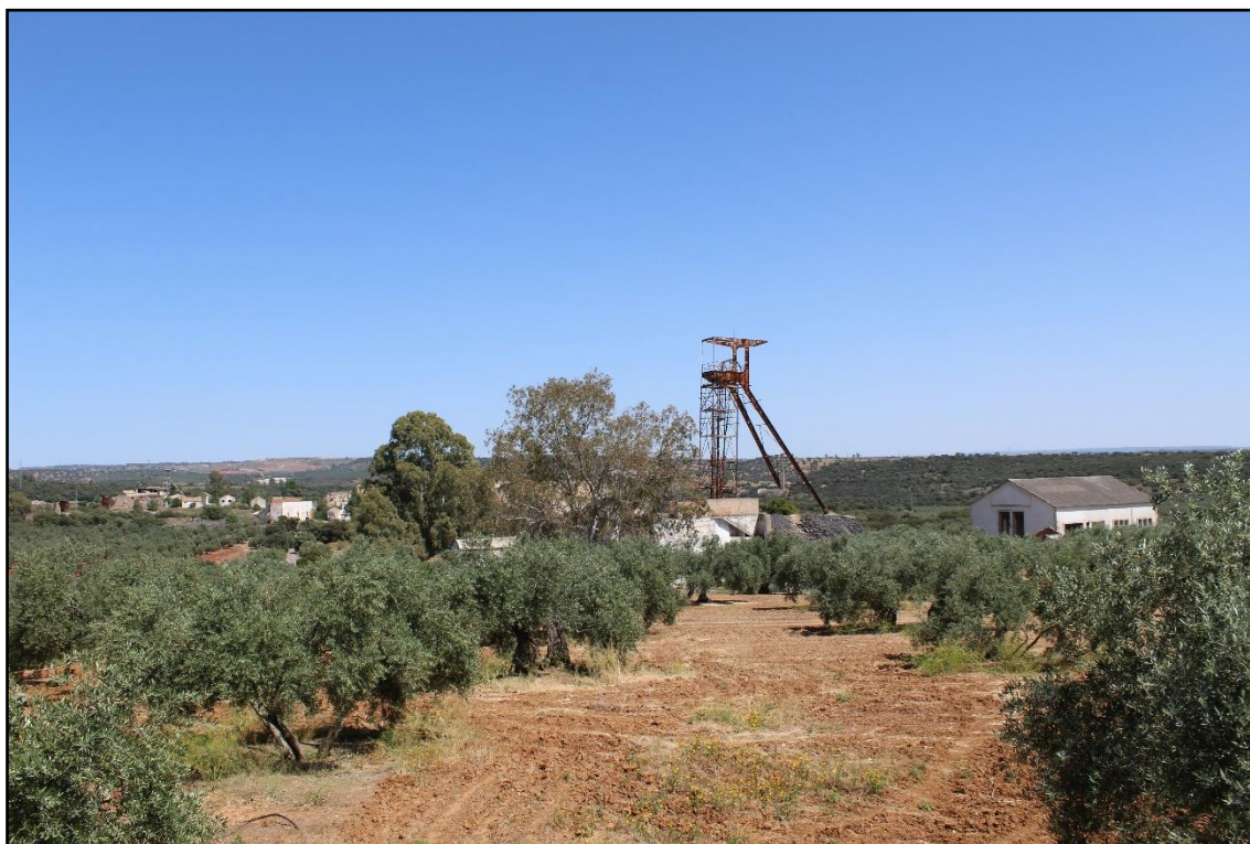
Fig. 2. Panorámica general del Pozo Nº3 Adaro. Imagen de los autores.
