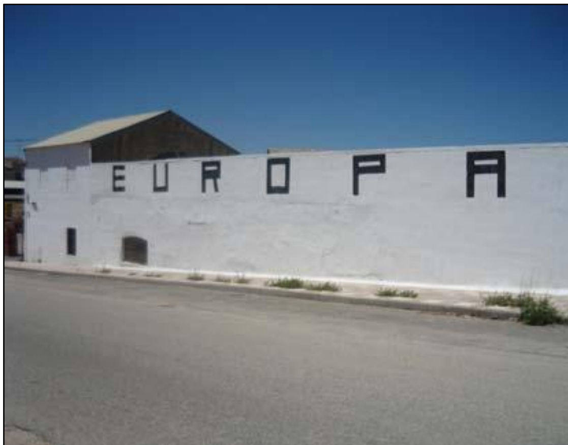
Fig. 2. Exteriores de la fábrica. Fuente: Ayuntamiento de Bailén.
