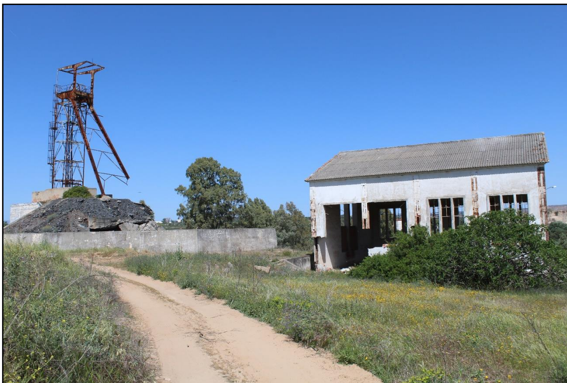
Fig. 3. Cabria metálica y edificio auxiliar. Nótese el avanzado estado de deterioro de la cabria metálica. Imagen de los autores.
