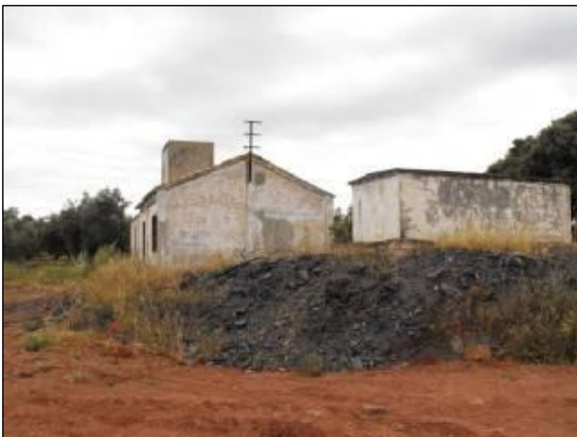
Fig. 3. Vista general de la explotación. Imagen de los autores.
