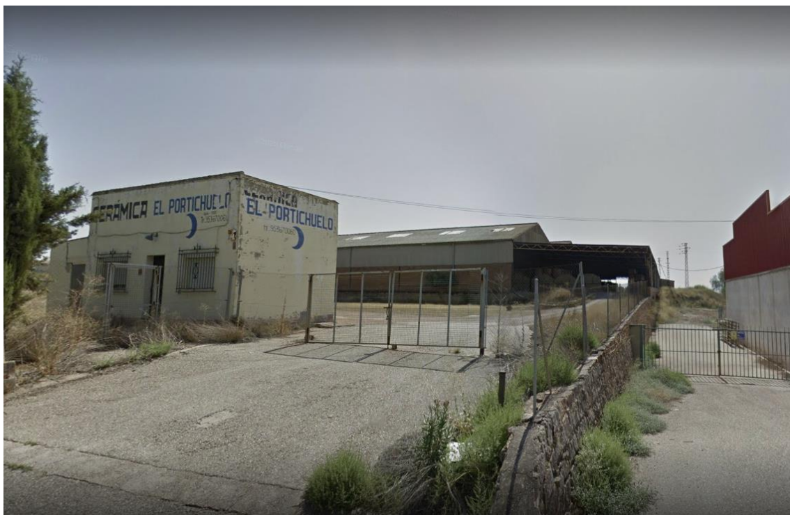
Fig. 2. Exteriores de la fábrica. Fuente: Ayuntamiento de Bailén.
