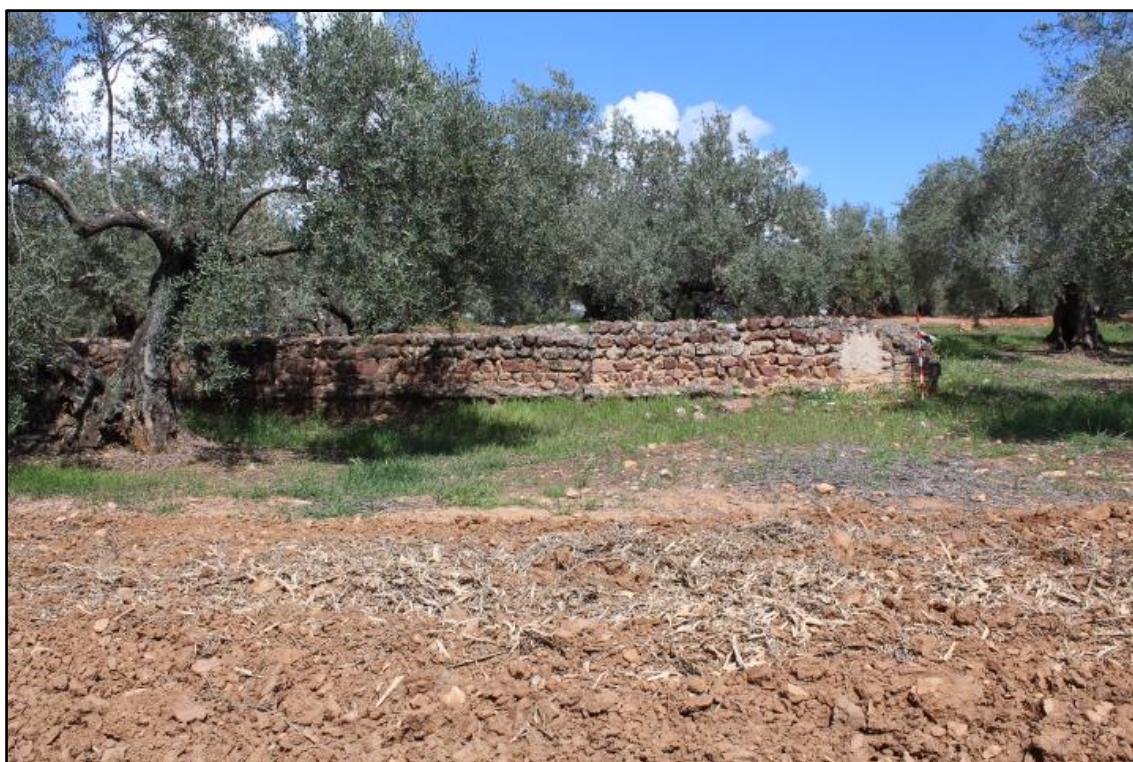
Fig. 2.. Vista general de la Alberca del Arroyo de la Virgen. Imagen de los autores.
