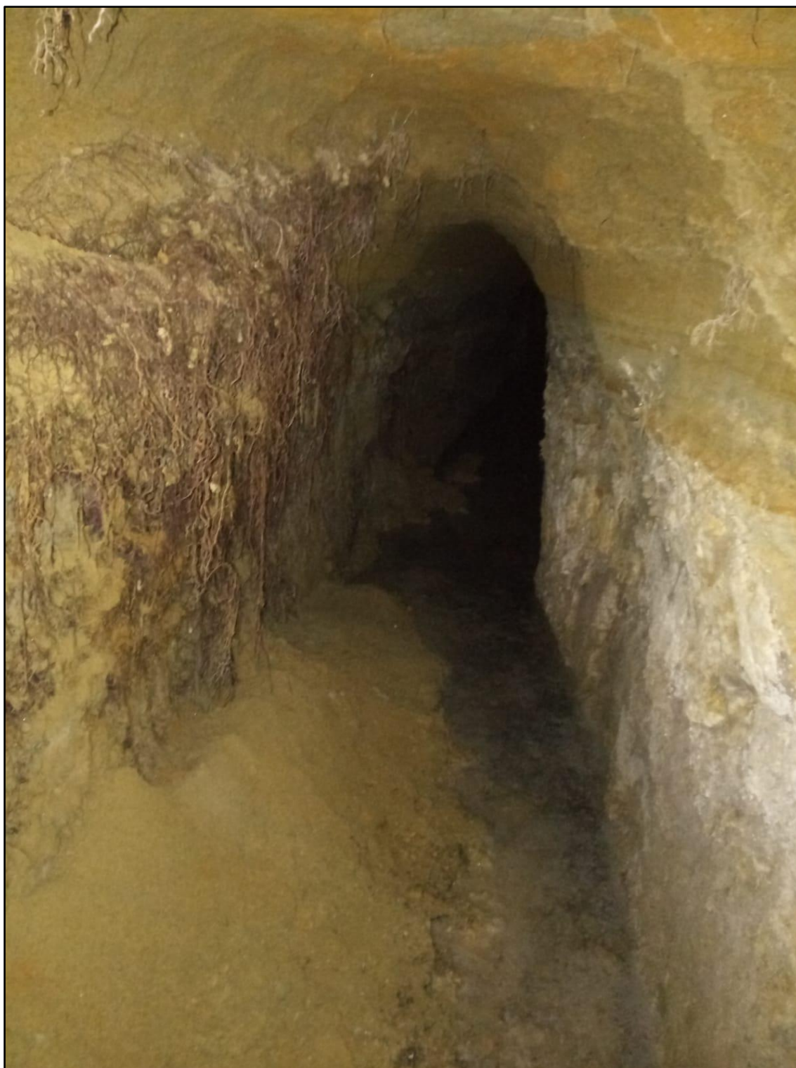
Fig. 2. Interior canal. Imagen de los autores.
