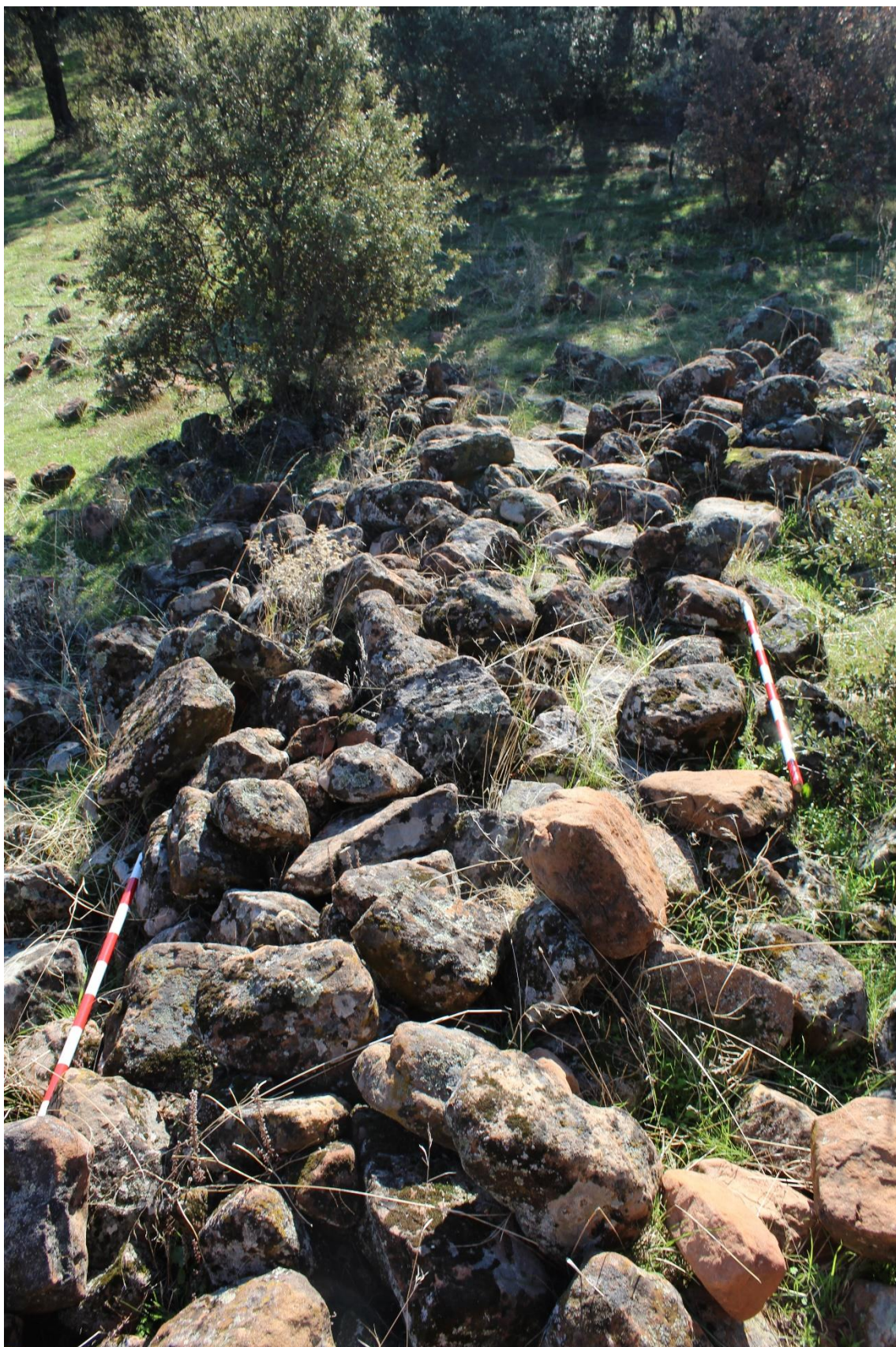
Fig. 3. Derrumbe de muro de torruca. Imagen de los autores.
