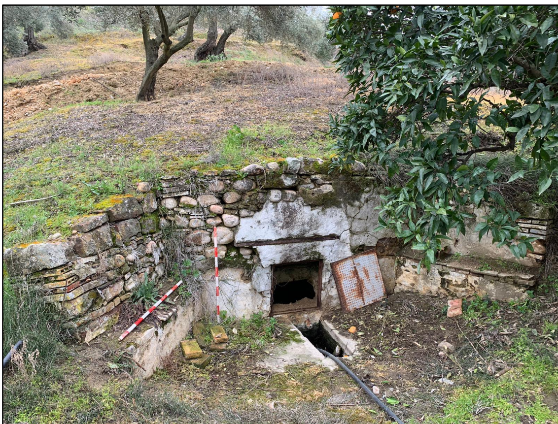
Fig. 3. Construcción hidráulica Alto de la Muela. Imagen de los autores.
