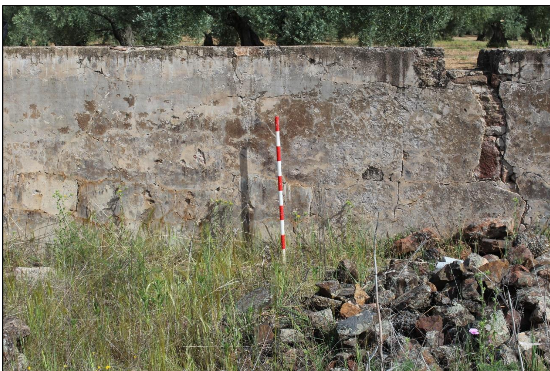
Fig. 3. Detalle de uno de los muros. Imagen de los autores.
