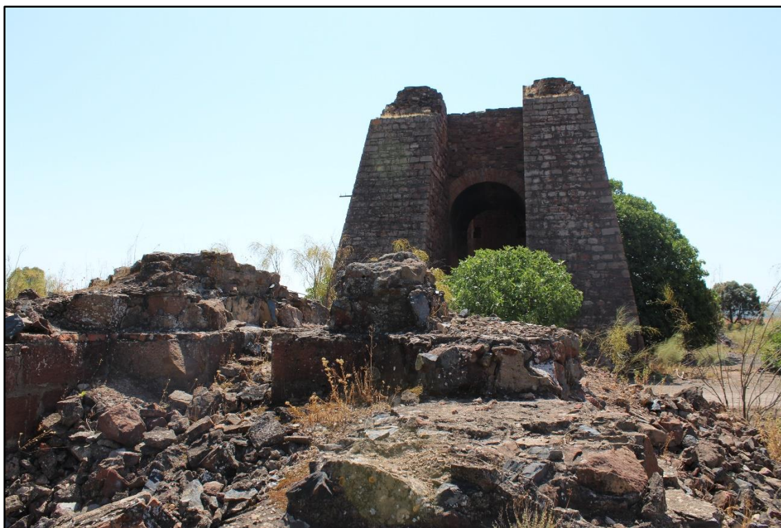
Fig. 2. Vista genera de la Mina de El Correo/Hysern. Imagen de los autores.
