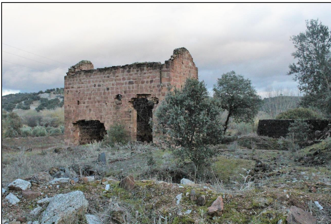
Fig. 2. Casa máquinas de extracción de balancín. Imagen de los autores.
