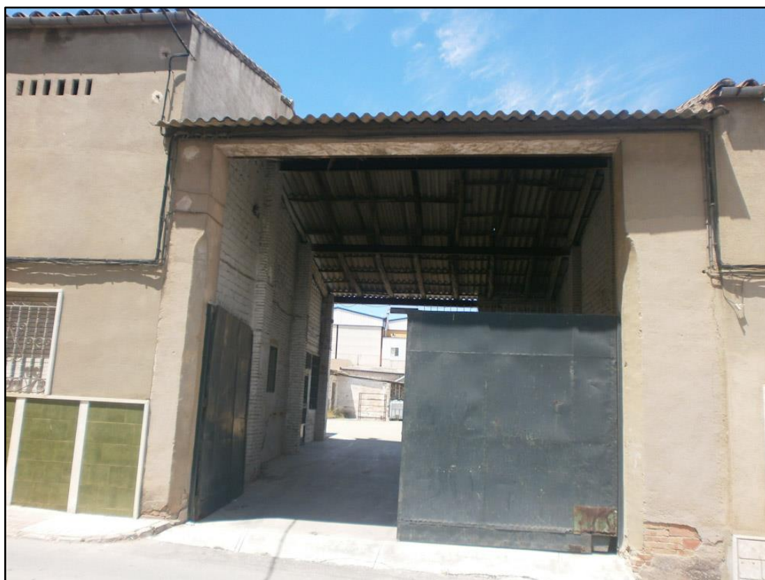
Fig. 2. Fachada. Imagen de los autores.
