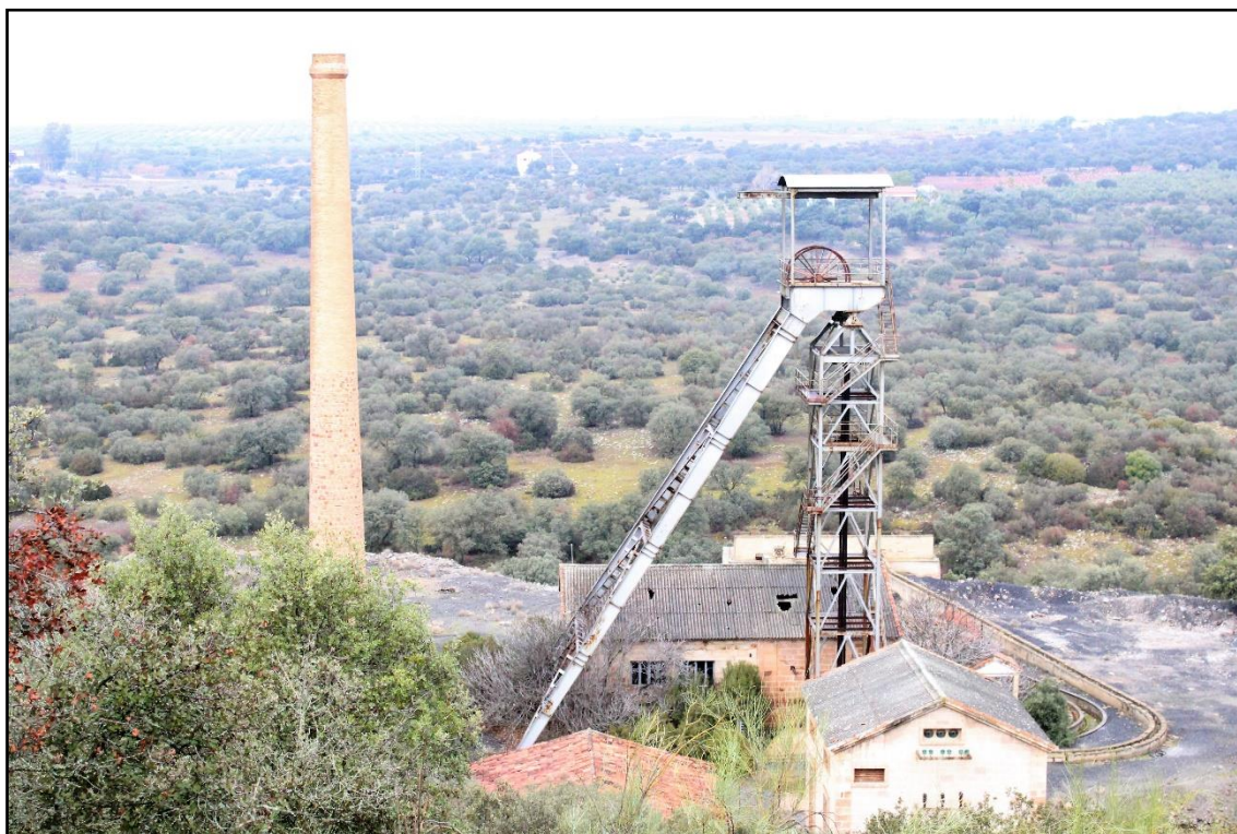
Fig. 2. La Mina de la Esmeralda vista desde el Cerro de Atalayones/Mina de Buenaplata. Imagen de los autores.
