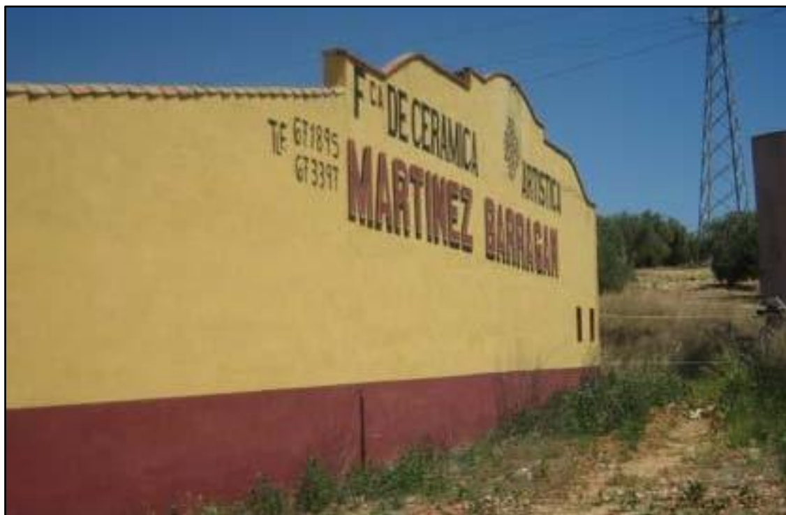
Fig. 2. Fachada. Fuente: Ayuntamiento de Bailén.
