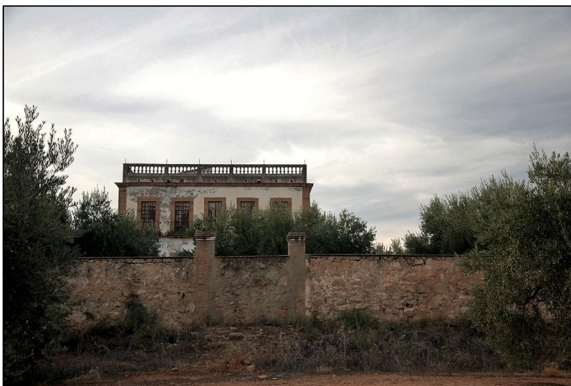
Fig. 2. Muro perimetral y bloque del cortijo. Imagen de los autores.
