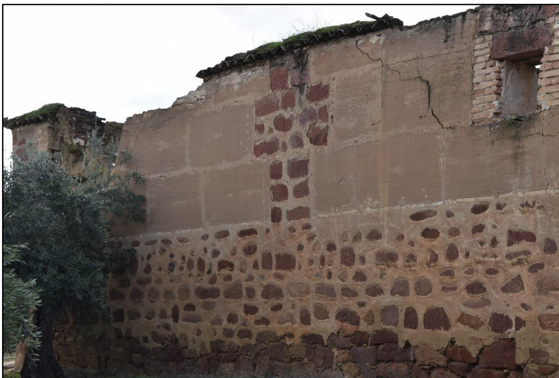
Fig. 4. Muro cortijo. Imagen de los autores.
