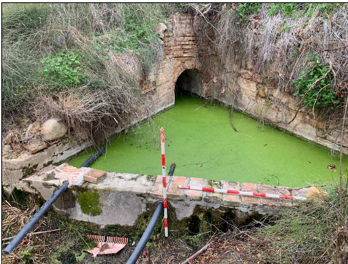
Fig. 2. Construcción hidráulica Alto de la Muela. Imagen de los autores.
