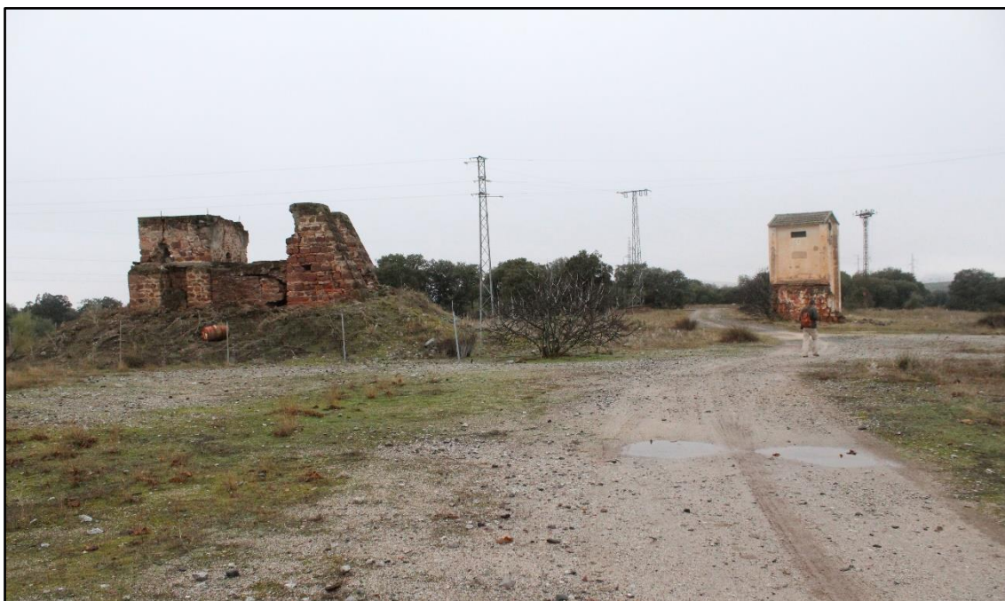
Fig. 2. Vista general de la Mina La Previsión. Imagen de los autores.
