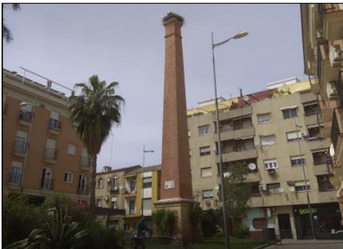
Fig. 2. Chimenea de la Plaza de las Cigüeñas. Imagen de los autores.
