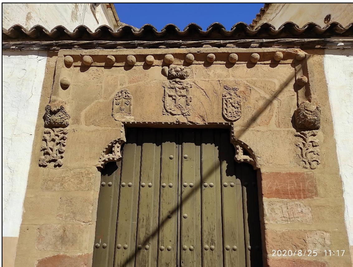
Fig. 2. Portada Gótica C/ Cristóbal Colón, Nº14. Imagen de los autores.
