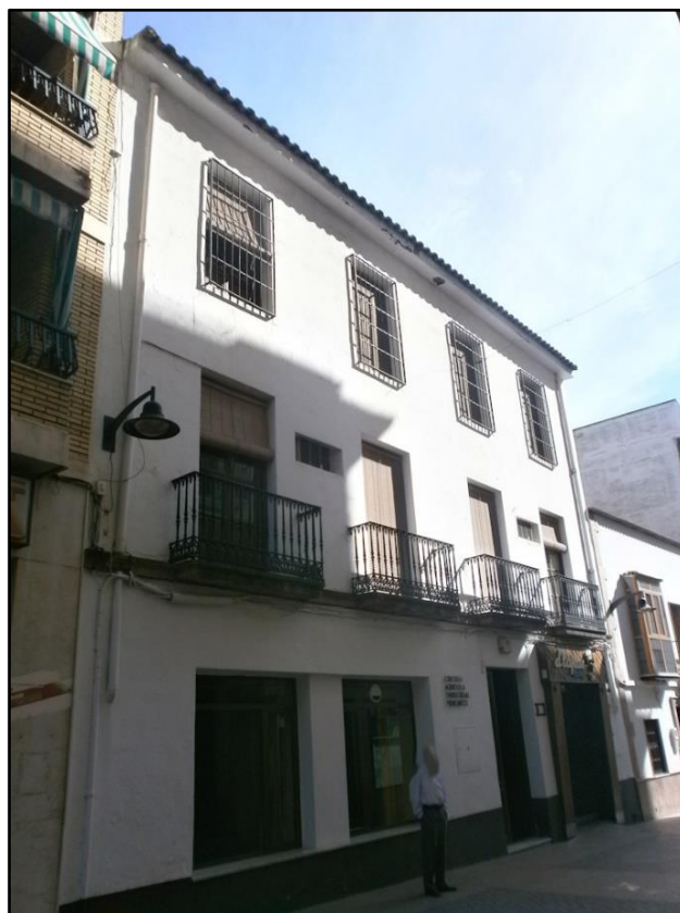
Fig. 2. Fachada C/ Zarco del Valle, Nº13. Imagen de los autores.
