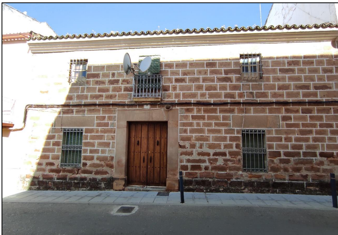
Fig. 2. Fachada C/ Silera, Nº8. Imagen de los autores.
