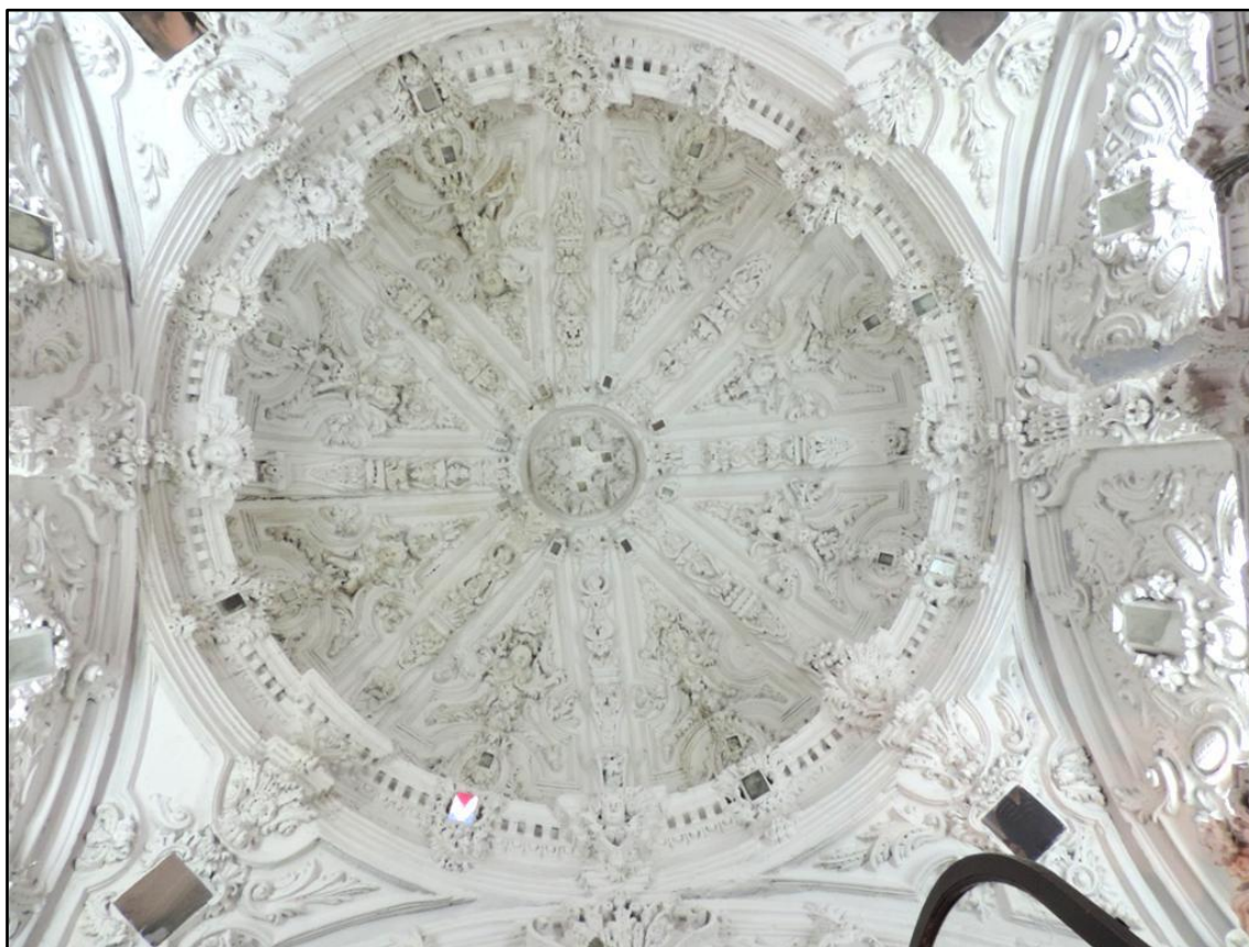
Fig. 4. Bóveda del camarín barroco. Fuente: ROSSI CABRERA (2015: 48).
