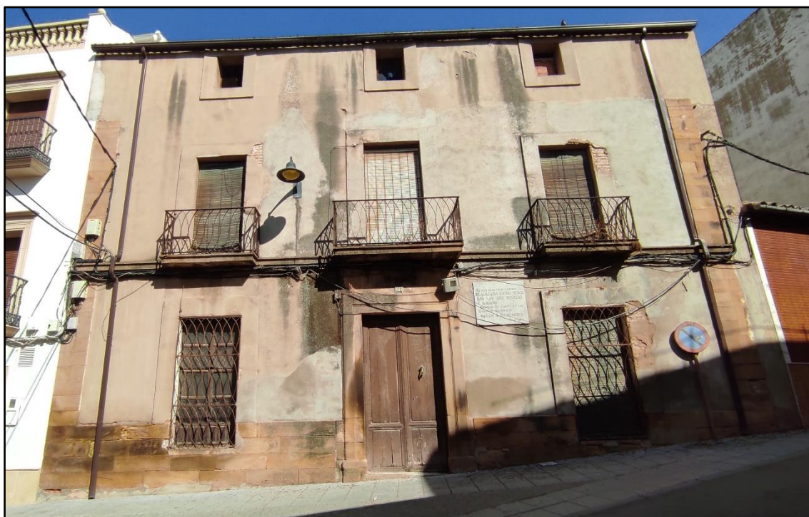
Fig. 2. Fachada C/ Silera, Nº28. Imagen de los autores.
