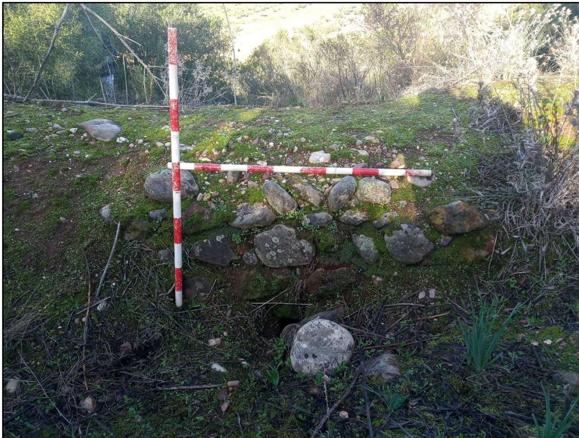
Fig. 3. Construcciones de mampostería. Imagen de los autores.
