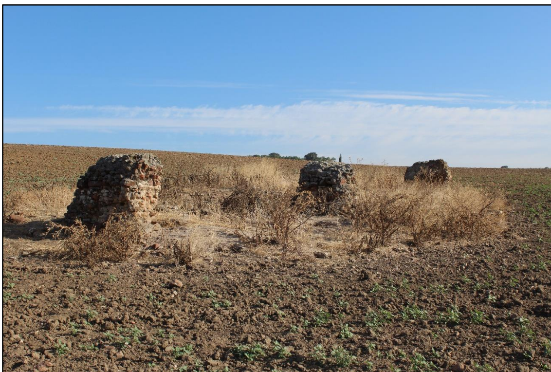
Fig. 4. Construcciones hidráulicas. Imagen de los autores.
