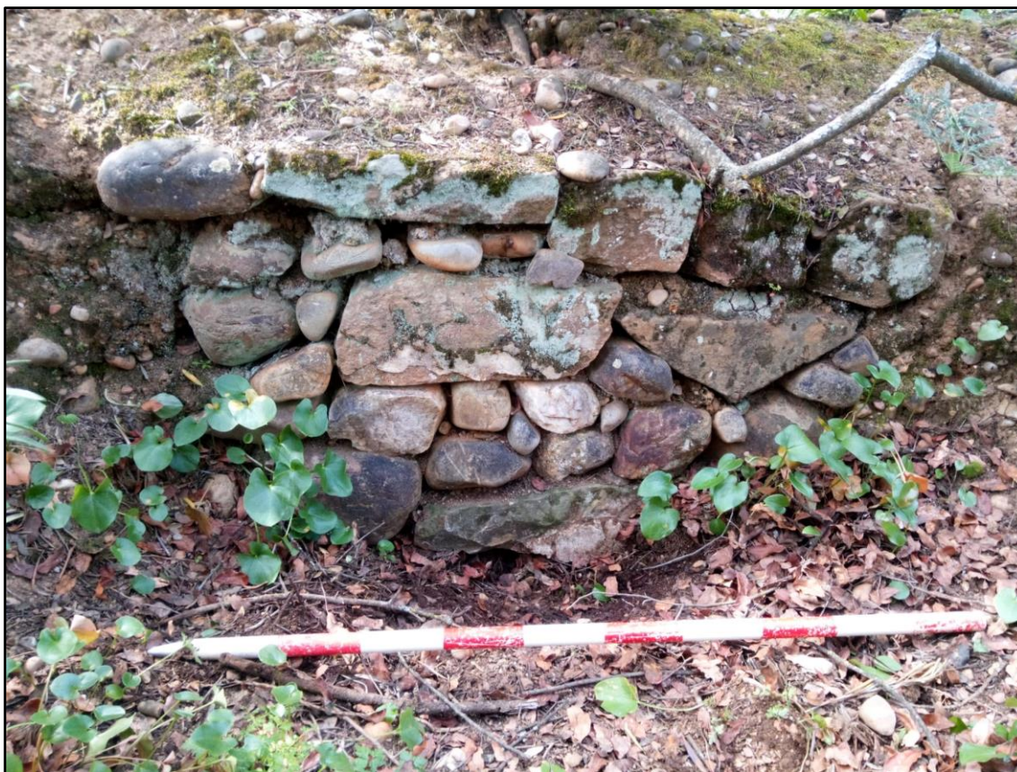
Fig. 2. Construcciones de mampostería. Imagen de los autores.
