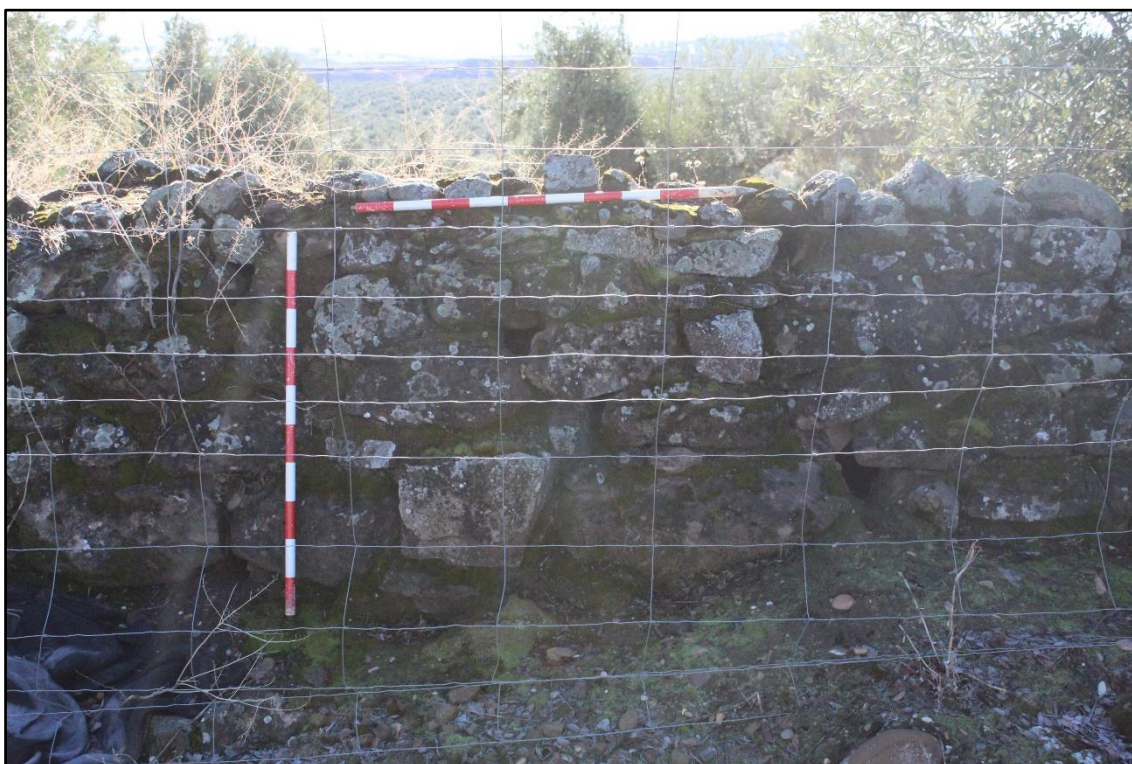
Fig. 5. Majano delimitador de fincas realizado con bloques de asperón. Imagen de los autores.
