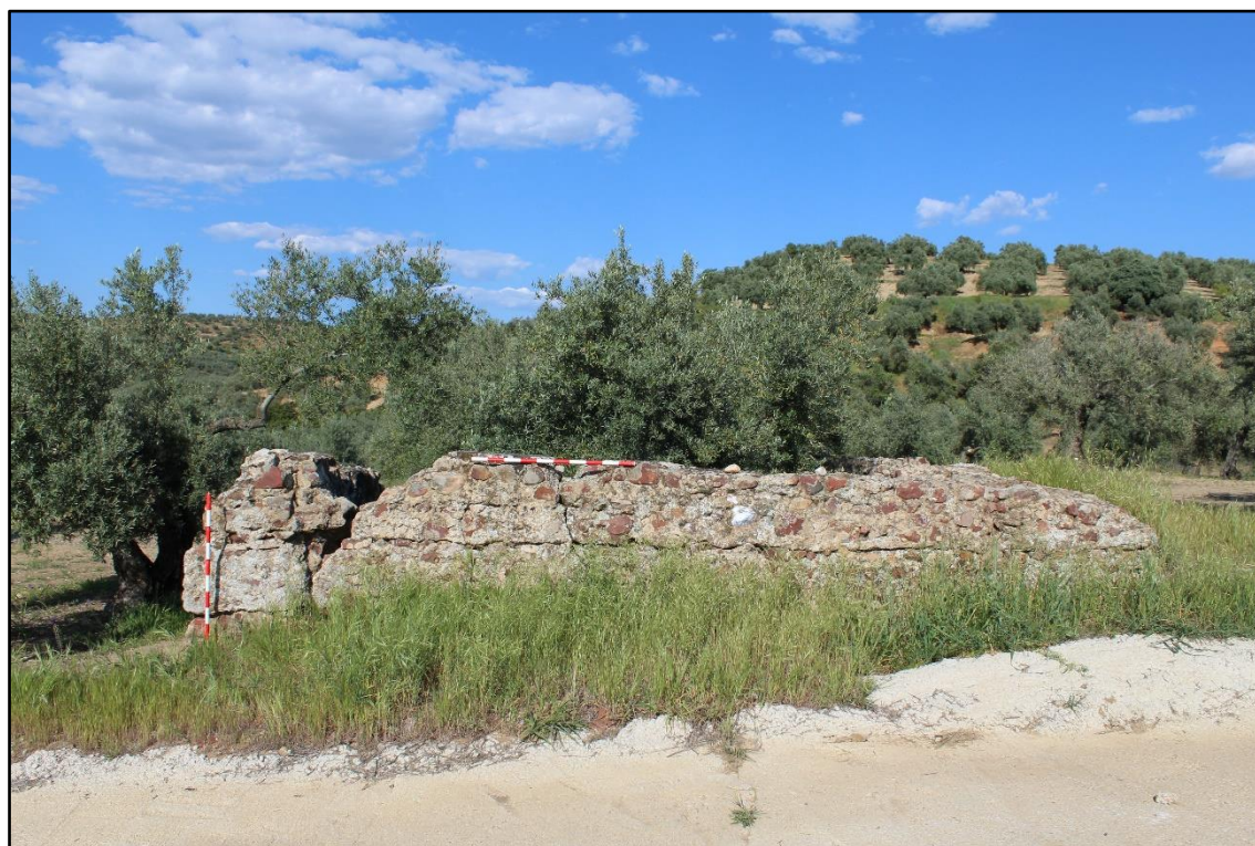
Fig. 5. Estructura hidráulica 2. Imagen de los autores.
