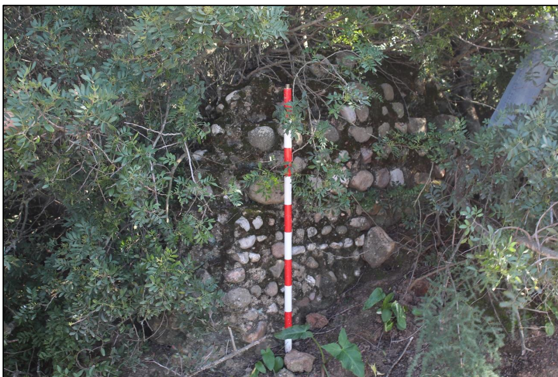
Fig. 2. Estructura hidráulica documentada. Imagen de los autores.
