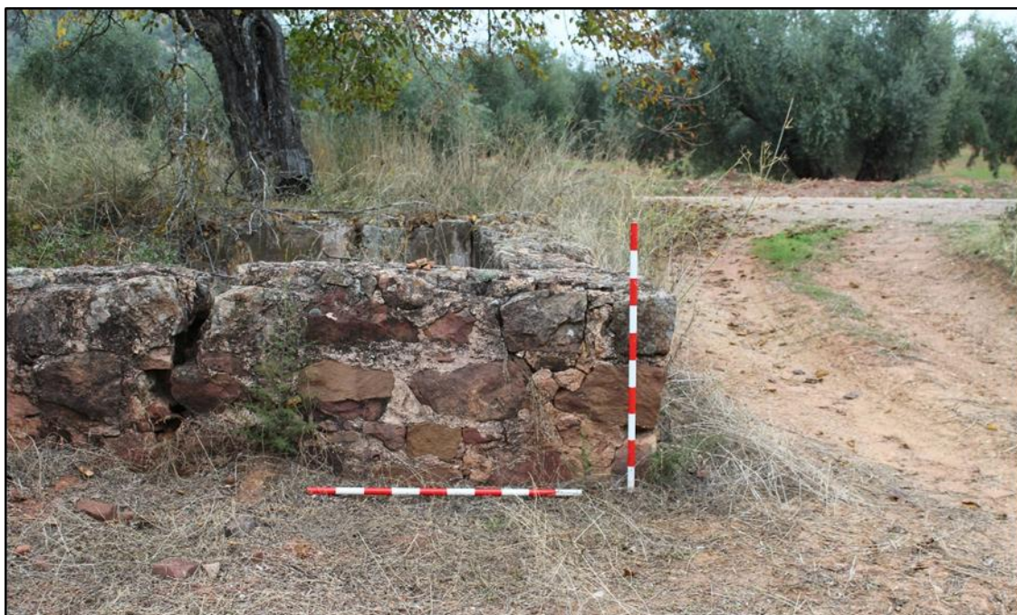
Fig. 2. Restos de una alberca documentada en Burguillos/Buenaplata. Imagen de los autores.
