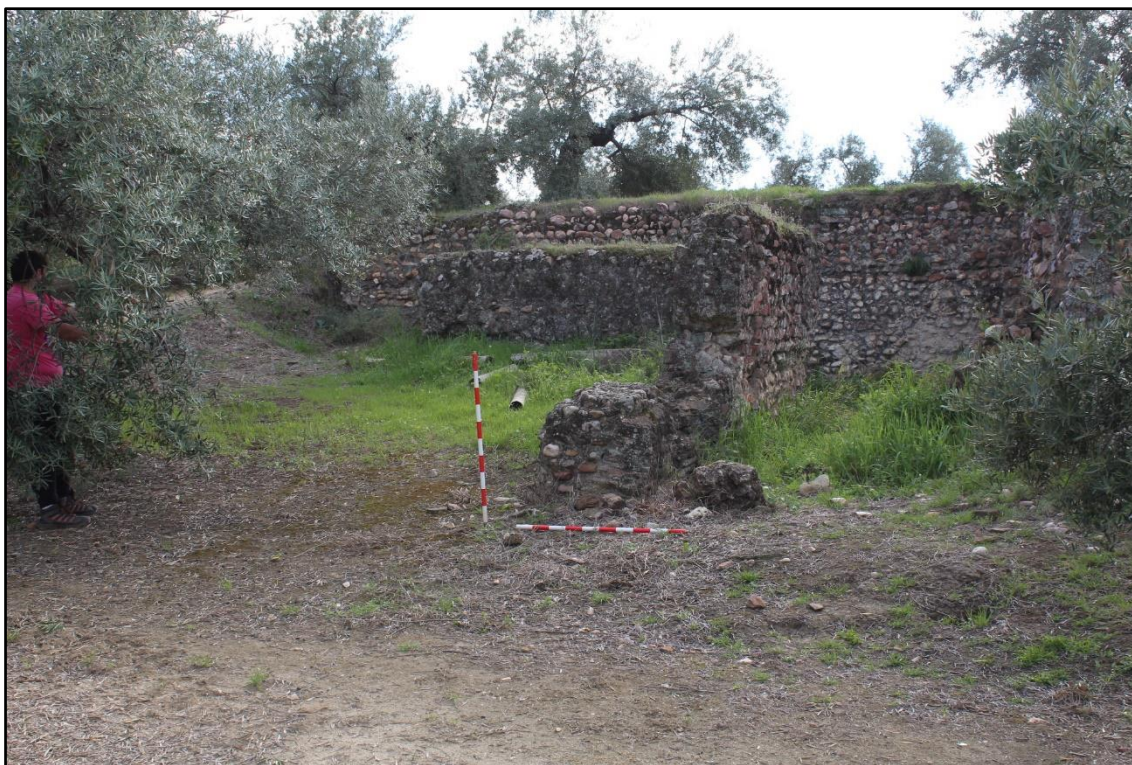
Fig. 2. Vista frontal estructura hidráulica 1. Imagen de los autores.
