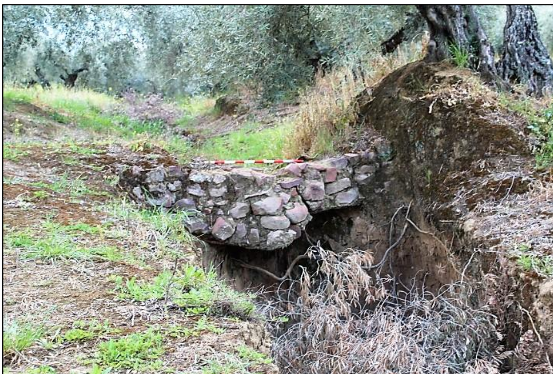
Fig. 3. Estructuras de opus caementicium . Imagen de los autores.
