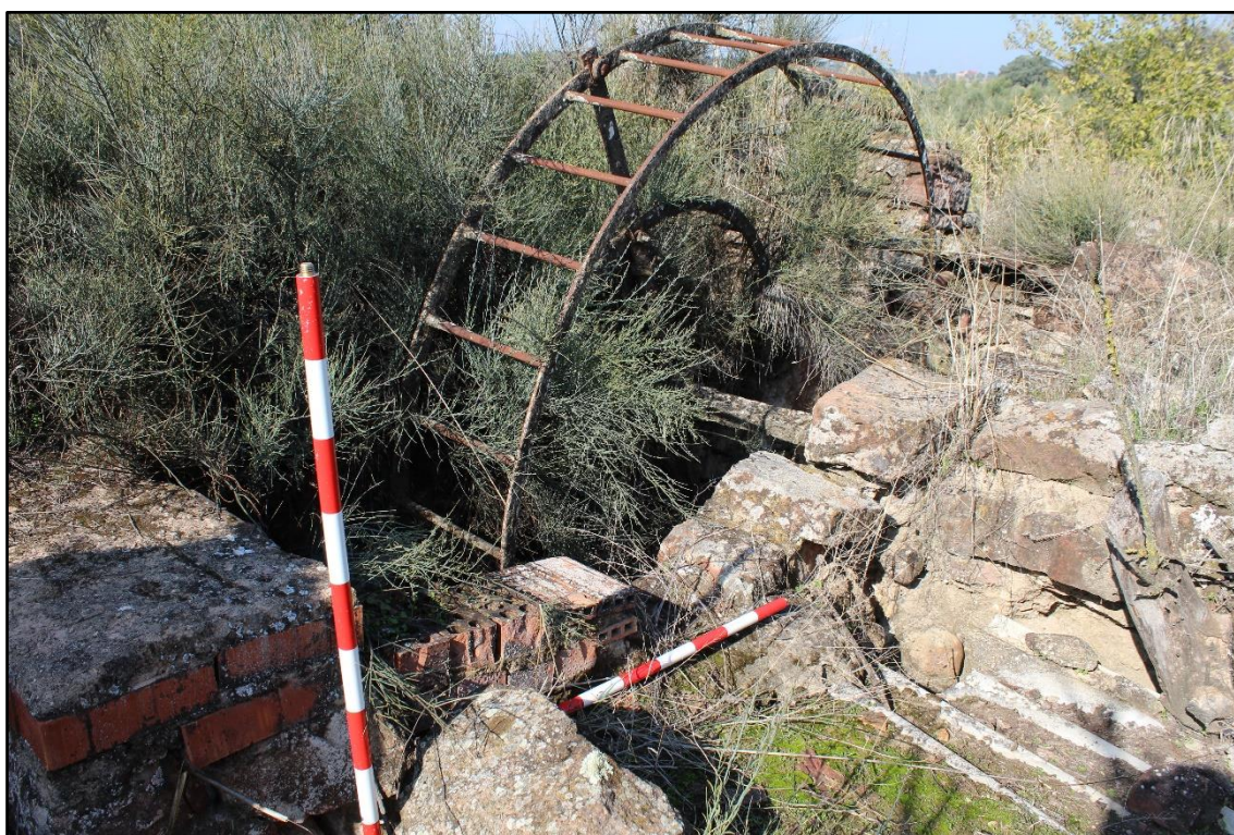
Fig. 2. Noria documentada en Casa de Don Federico. Imagen de los autores.
